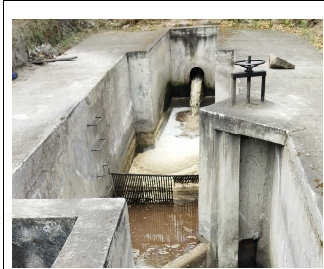
Gráfico No. 01 Estructura de captación lateral
