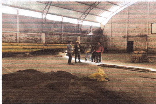
Foto 77. Trabajos de mantenimiento en el Coliseo Deportivo, de la cabecera parroquial de Tixán
