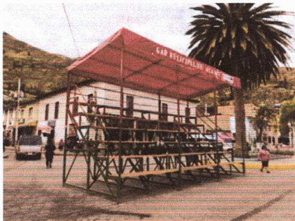
Foto 8 Graderío metálico armado, en la Av. 5 de Junio, de la ciudad de Alausí
