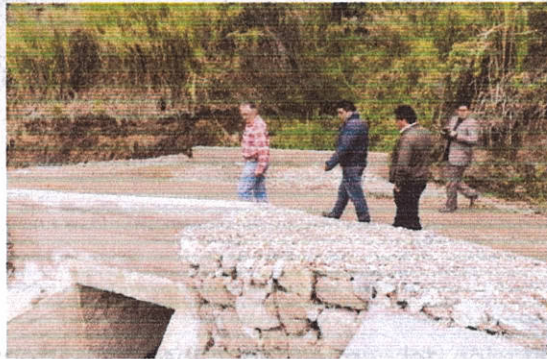
Foto 71. Construcción de un puente en la vía de ingreso a la comunidad San José, parroquia Sibambe
