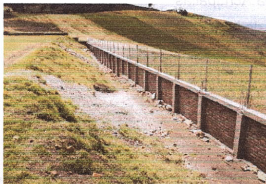
Foto 78. Construcción del cerramiento del estadio deportivo de la comunidad Llactapamba, parroquia matriz
