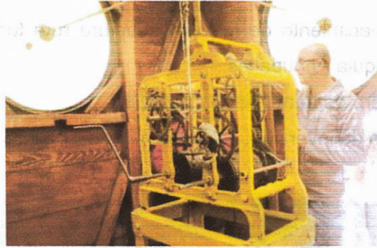
Foto 14. Mantenimiento del reloj Público de la ciudad de Alausí
