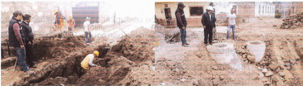
Foto 37. Construcción del plan maestro de agua potable en la cabecera parroquial de Guasuntos
