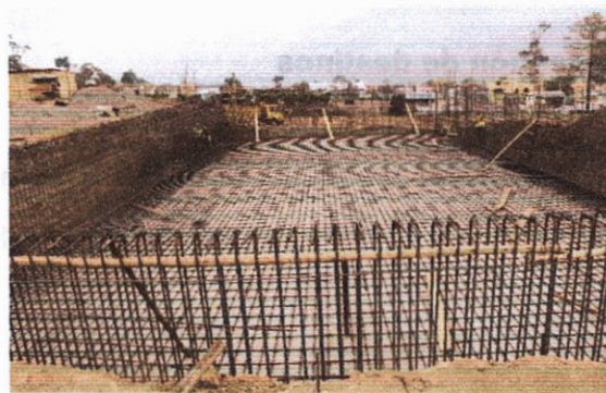
Foto 81. Construcción del Complejo Deportivo, en la cabecera parroquial de Sibambe
