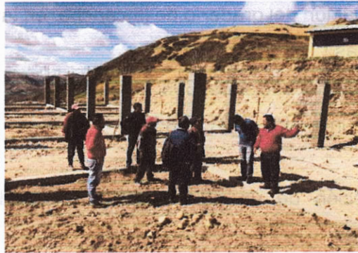
Foto 73. Construcción del Centro de Desarrollo Humano, comunidad Chalaguán, parroquia Tixán
