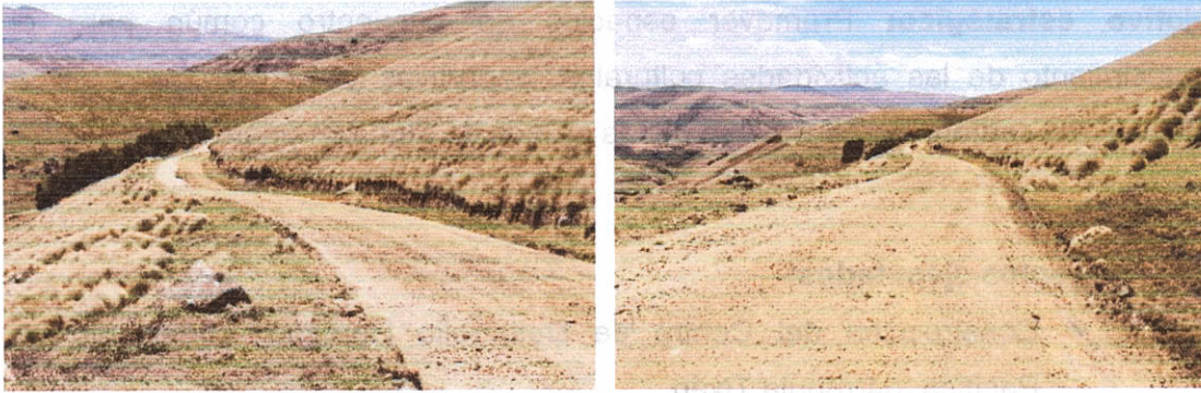
Foto 70. Mejoramiento de la vía Achupallas-Dolorosa-Pomacocha-Jubal
