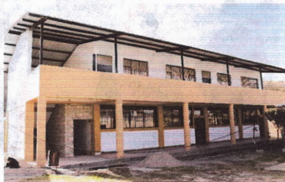
Foto 76. Construcción de un aula escolar para la Unidad Educativa Juan Francisco Yerovi, parroquia Tixán
