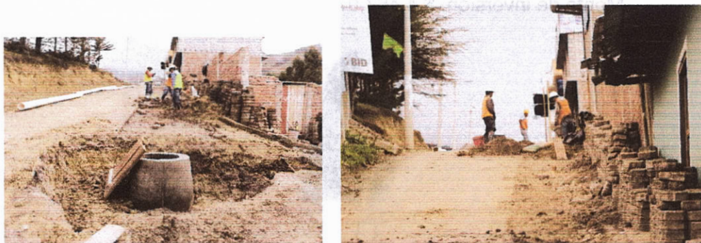
Foto 65. Trabajos para la construcción del Plan Maestro de agua potable, alcantarillado pluvial y sanitario, en la cabecera parroquial de Achupallas
